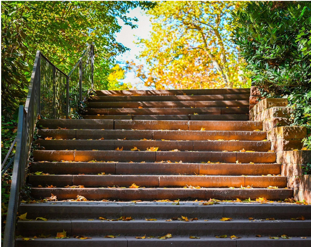
Instalaciones de construcción y obra civil: estatua (izquierda), fuente ornamental (derecha), escalera (abajo centro).
