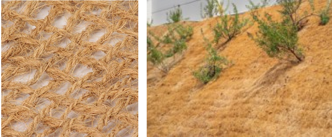
Geotextil de fibra de coco y talud revegetado.
