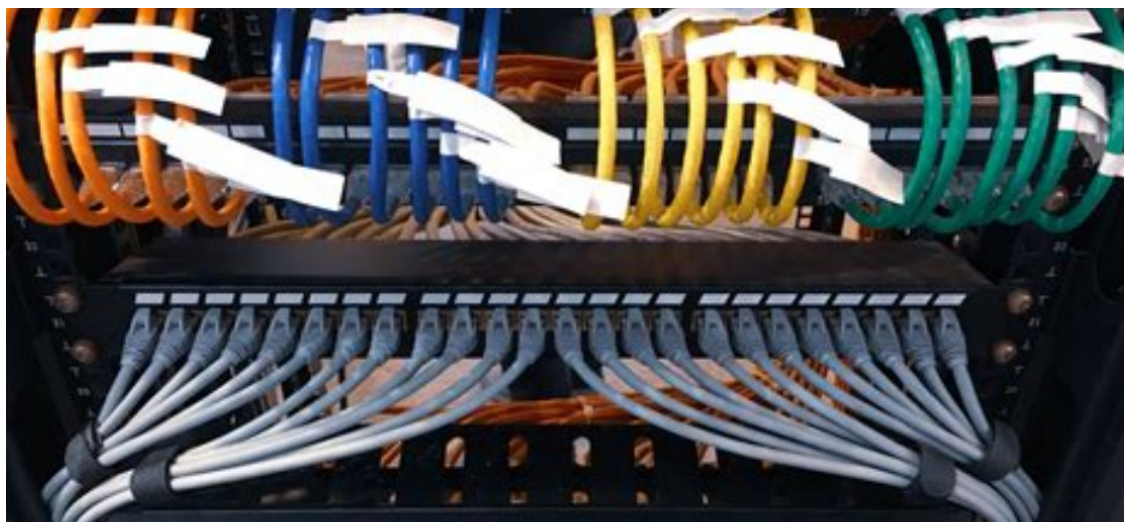
Ejemplo de cableado correctamente organizado y etiquetado en un rack de comunicaciones, que facilita el mantenimiento, la identificación de enlaces y la intervención técnica segura.
