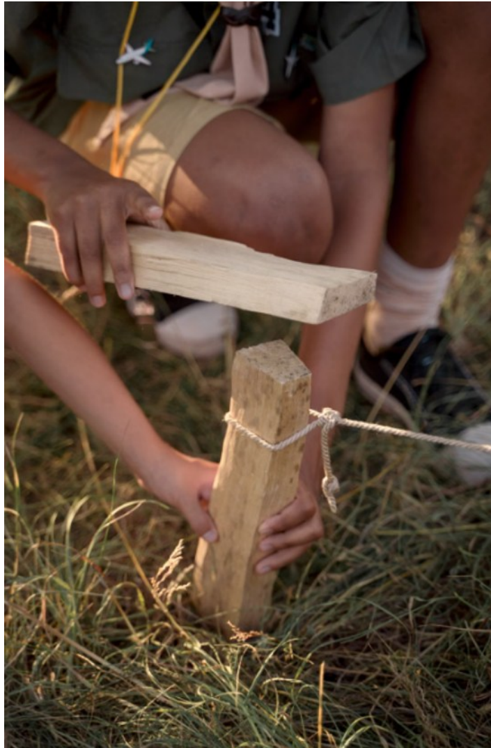
Estaca de madera para señalar un punto en el replanteo
