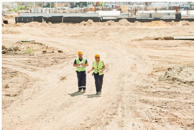
Durante el replanteo es necesario usar chalecos reflectantes de alta visibilidad
